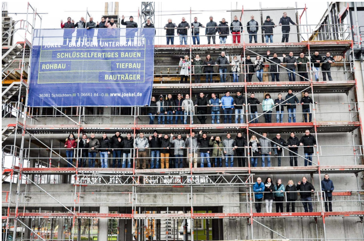
Der Rohbau der ersten vier Stockwerke steht bereits.
